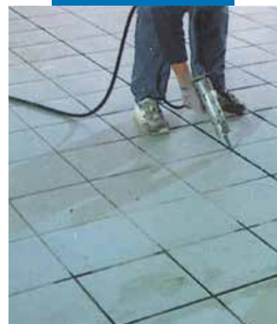
Spoinowanie posadzki za pomocą pistoletu pneumatycznego
