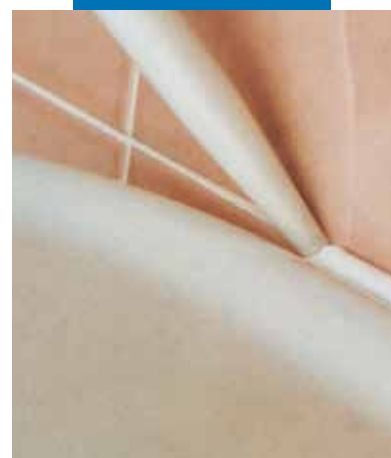
Spoinowanie ceramiki sanitarnej przy użyciu Mapesil AC
