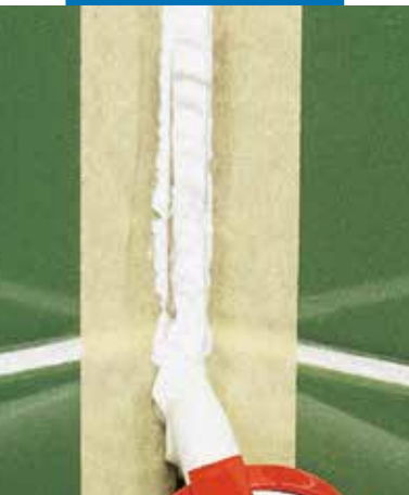
Spoinowanie przy użyciu Mapesil AC
