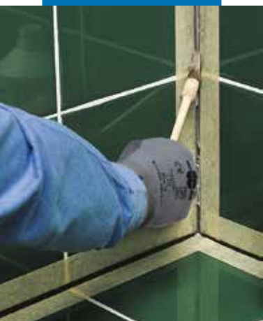
Gruntowanie boków szczeliny przy użyciu Primer FD
