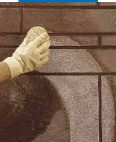
Czyszczenie i profilowanie fug gąbką
