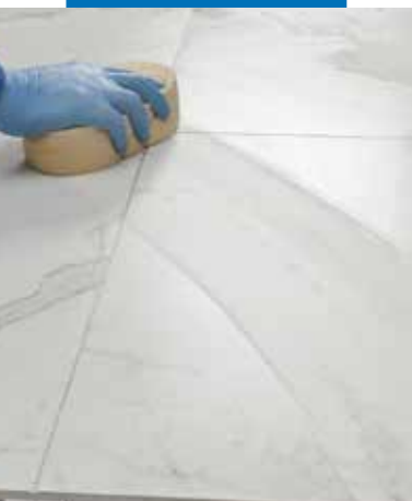
Czyszczenie i profilowanie spoin twardą gąbką celulozową
