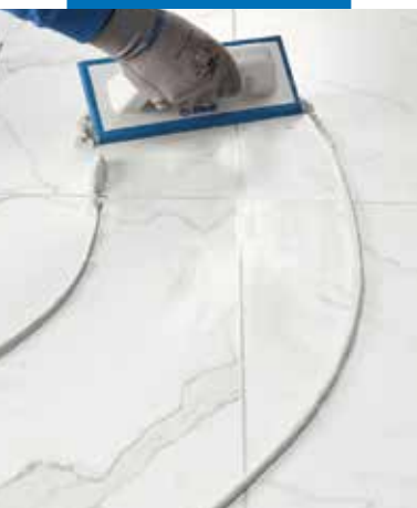
Spoinowanie płytek imitujących kamień naturalny
