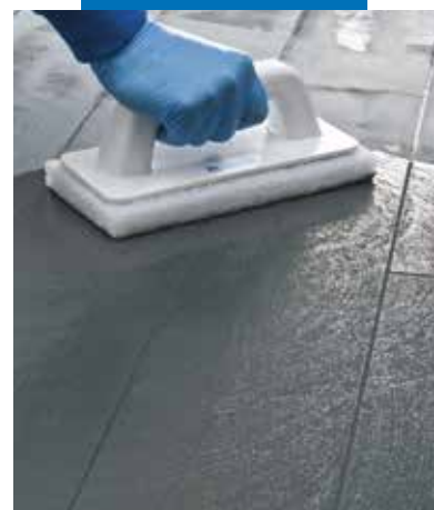
Czyszczenie i profilowanie fug na ścianie przy użyciu gąbki
