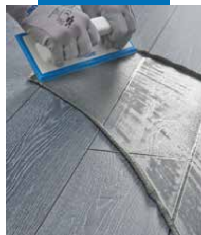
Nanoszenie zaprawy Ultracolor Plus pacą gumową na ścianie
