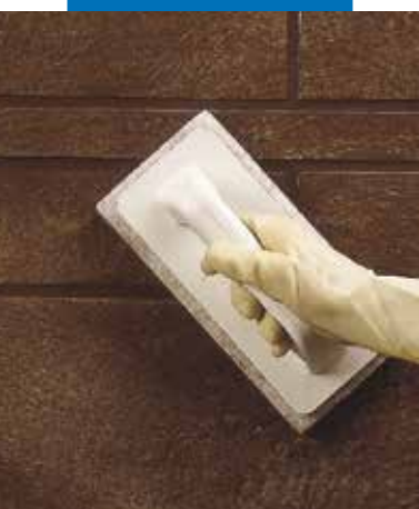
Czyszczenie spoin za pomocą Scotch-Brite® (zaprawa częściowo stwardniała)
