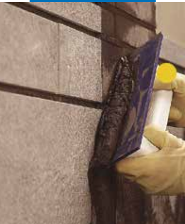
Nanoszenie zaprawy Ultracolor Plus przy użyciu gumowej pacy
